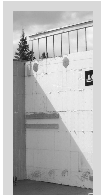
Figure 4 : Détails des coffrages isolants
