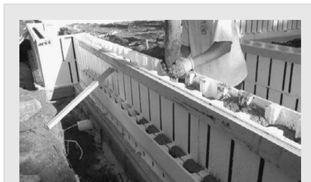
Figure 2 Coulage d'un mur en CBI
