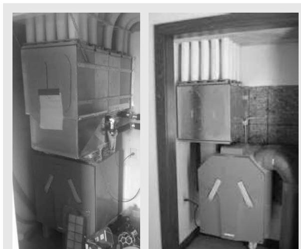
Figure 4.5 Exemples de VRC dans un appartement desservant plusieurs zones. Puisque l'appareil à gauche dessert l'habitation d'une famille élargie, il comporte beaucoup plus de conduits (un par pièce) que s'il desservait un logement type dans un immeuble collectif. La taille de l'appareil est comparable à celle d'un appareil qui serait utilisé dans un appartement (images reproduites avec l'aimable autorisation de Bernhardt Contracting Ltd.).
