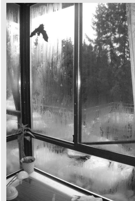
Figure 1.2 Condensation sur la surface intérieure des fenêtres.
