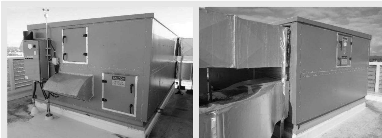
Figure 4.4 VRC central adapté à un immeuble collectif de 11 étages. L'appareil fournit une ventilation d'environ 6 000  $\text{m}^3/\text{min}$  à 90 logements.
